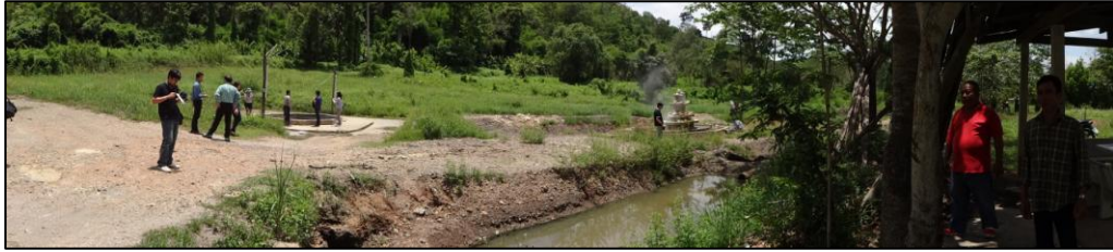
ภาพที่ 4-22 สภาพโดยทั่วไปของสิ่งก่อสร้างที่ชำรุดใช้งานไม่ได้บริเวณพุร้อนโป่งปุเพียง
