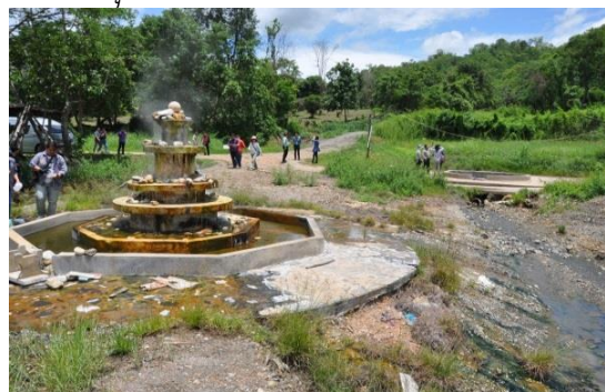
ภาพที่ 4.10 บ่อน้ำร้อนที่มีการก่อสร้าง
