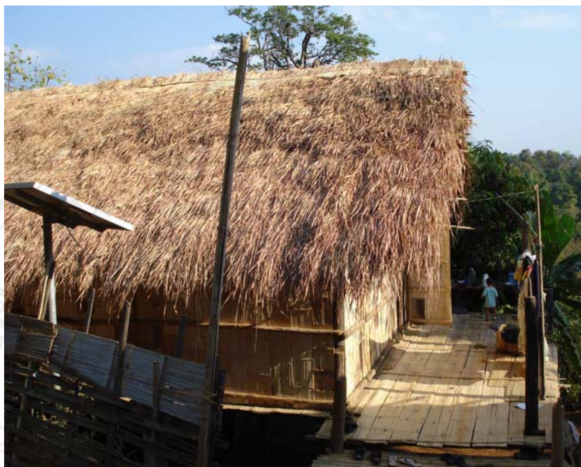
ภาพที่ 5.2 การสร้างตัวบ้านปิดบังเสาปูน “บ้านนาสี”
