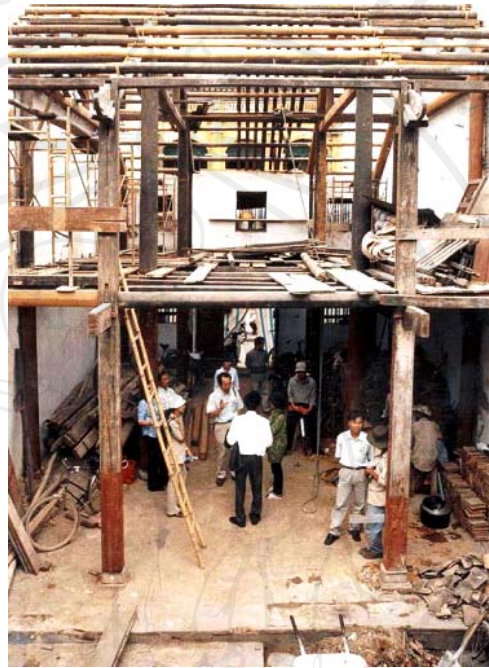
ภาพที่ 3.4 การบูรณะซ่อมแซมอาคารเก่าแก่
