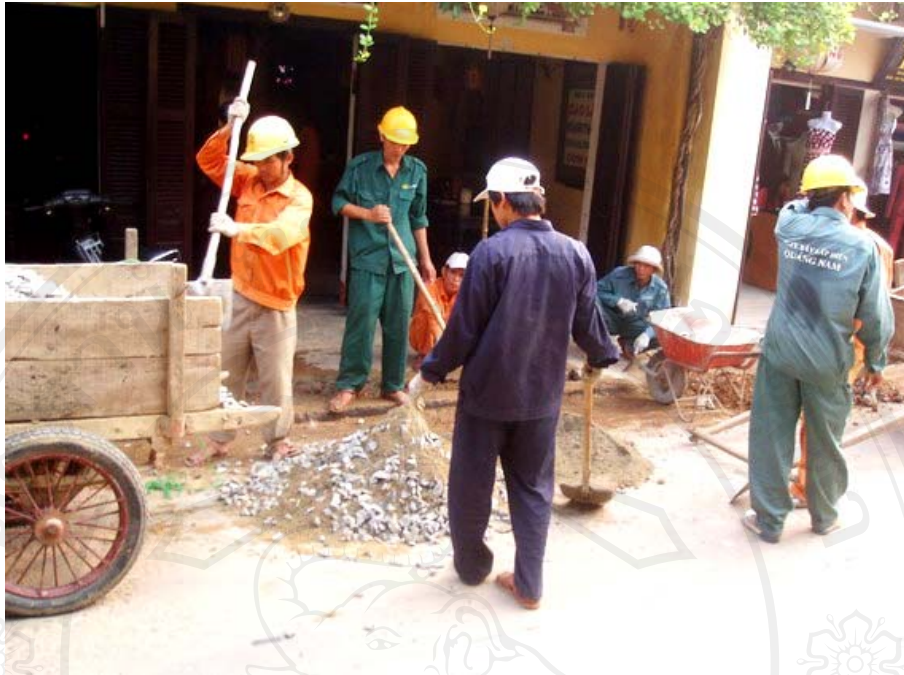
ภาพที่ 4.8 เจ้าหน้าที่กำลังซ่อมแซมถนน
