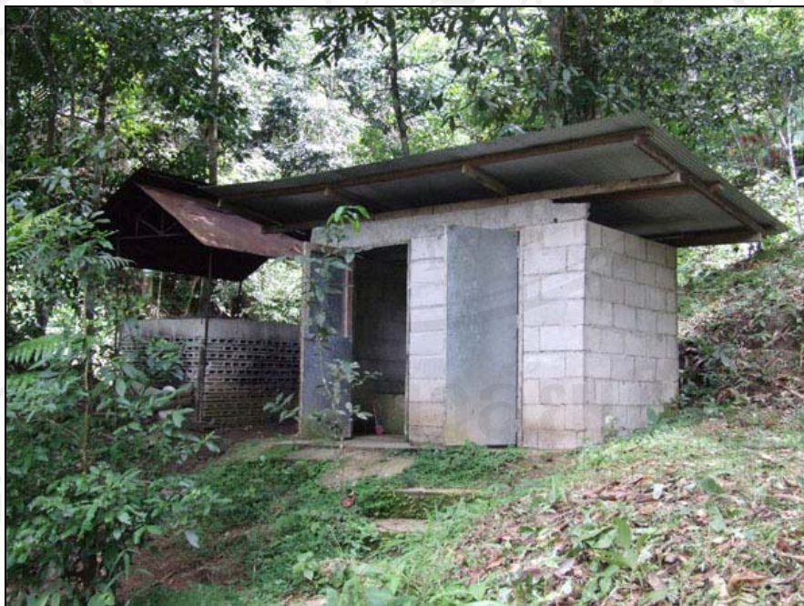
รูป 4.10 ห้องน้ำที่สร้างขึ้นใหม่บริเวณด้านข้างน้ำตกแม่กำปอง ที่อยู่ติดกันคือเตาเผาขยะ
