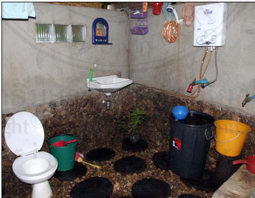
รูป 4.6 ห้องน้ำห้องส้วมภายในบ้านพักโฮมสเตย์
