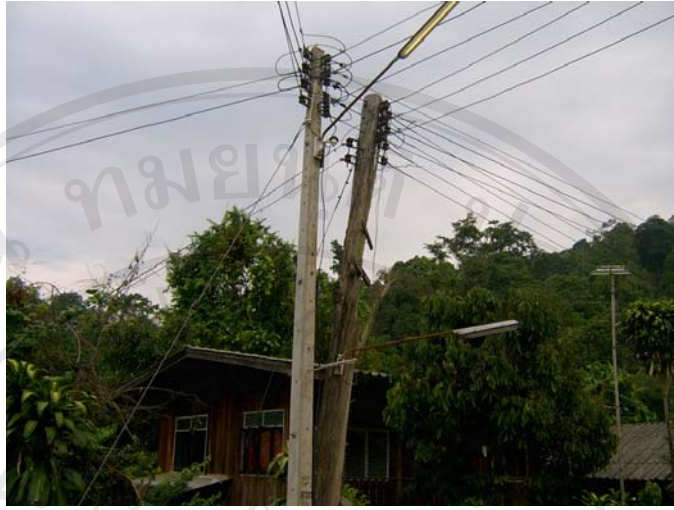
รูปภาพที่ 3.4 แสดงภาพการใช้ไฟฟ้าพลังน้ำ (เสาไม้) และไฟฟ้าส่วนภูมิภาค (เสาปูน)
