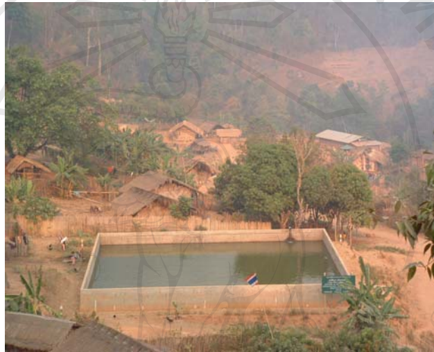
ภาพที่ 7 ถังเก็บน้ำในโครงการฯ
