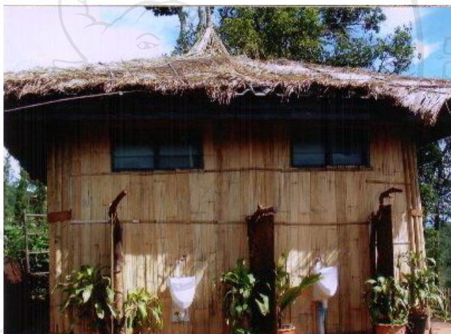
ภาพที่ 44 ห้องสุขาสาธารณะบริเวณลานกางเต็นท์
