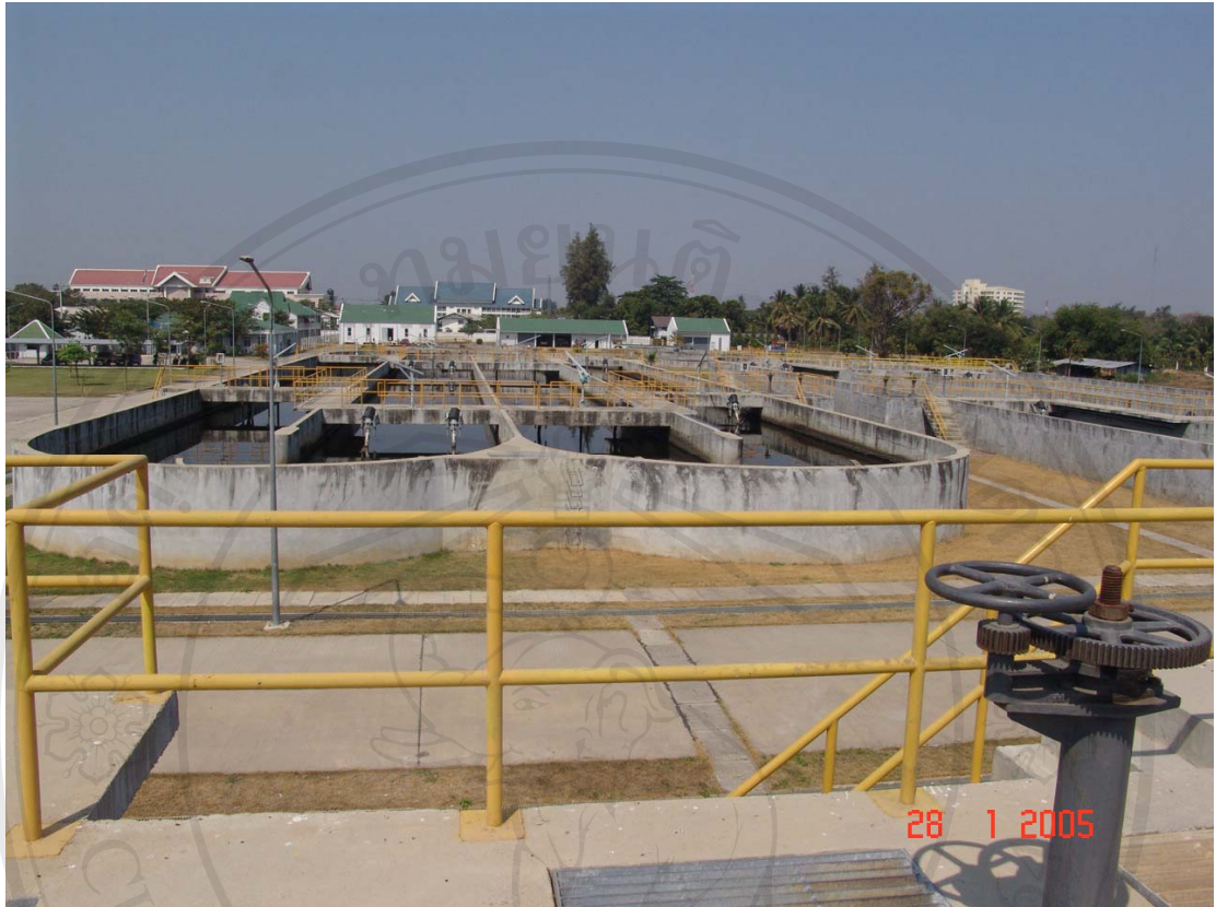
ภาพที่ 4.22 แสดงบ่อเติมอากาศซึ่งเป็นหัวใจการทำงานของระบบบำบัด แบบ Oxidation Ditch
