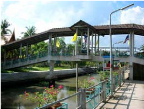
ภาพที่ ข-7 สะพานคอนกรีตข้ามคลองศาลา
