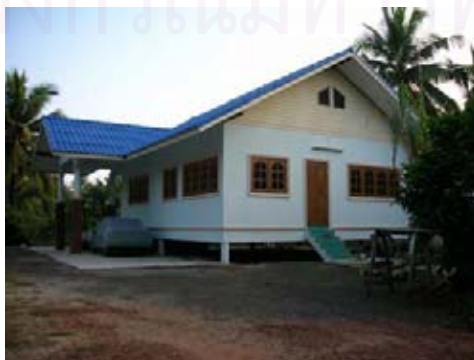
ภาพที่ 4-23 แสดงอาคารสร้างใหม่ของบ้าน นายจรูญ เจือไทย
