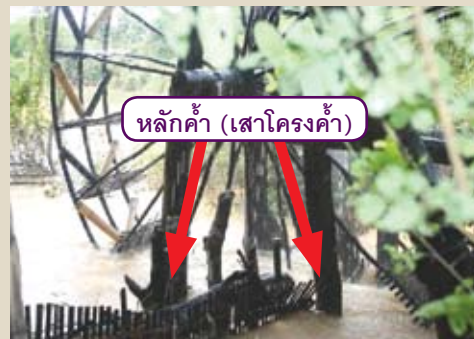
ภาพที่ 5-1 หลักค้ำ (เสาโครงค้ำ)
