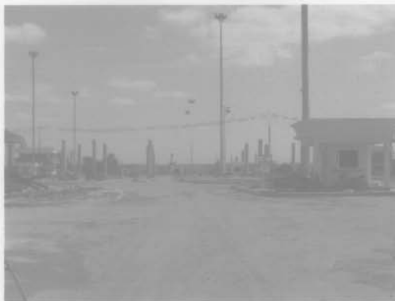
ภาพที่ 5.6 อาคารควบคุมตั้งอยู่บริเวณทางเข้าตัวสะพานข้ามแม่น้ำโขงแห่งที่ 2
