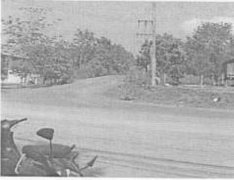
ภาพที่ 2.17 ถนนใหญ่ในพื้นที่ที่กำลังปรับปรุง ก่อสร้าง
