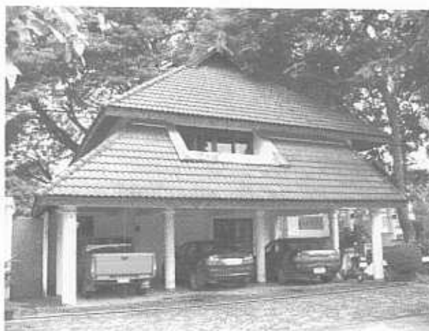
ภาพที่ 4.43 แสดงบริเวณพื้นที่จอดรถ
