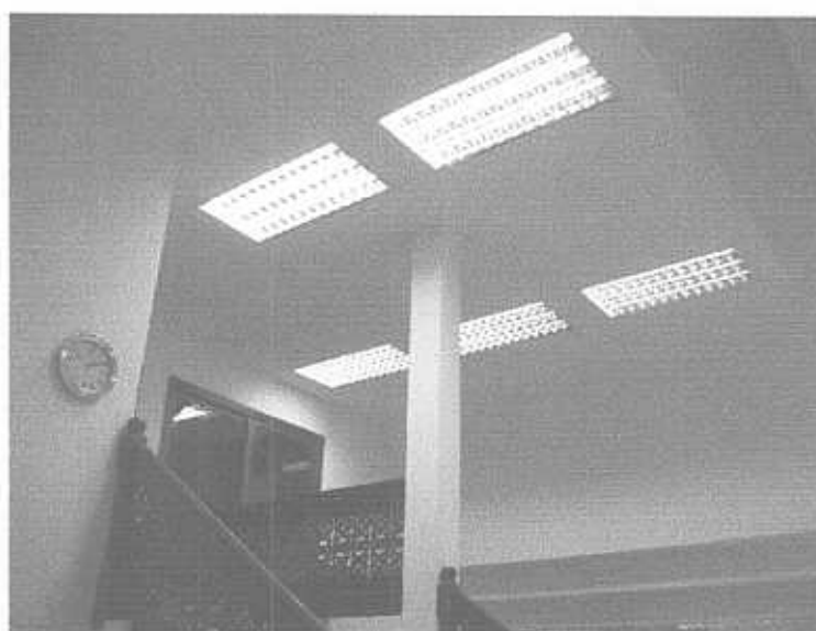
ภาพที่ 4.12 แสดงแสงสว่างภายในอาคาร
