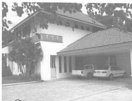
ภาพที่ 4.115 แสดงบริเวณพื้นที่จอดรถ
