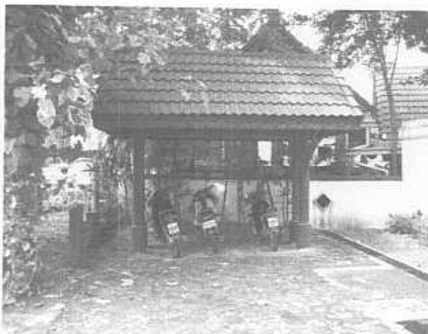
ภาพที่ 4.44 แสดงบริเวณพื้นที่จอดรถ
