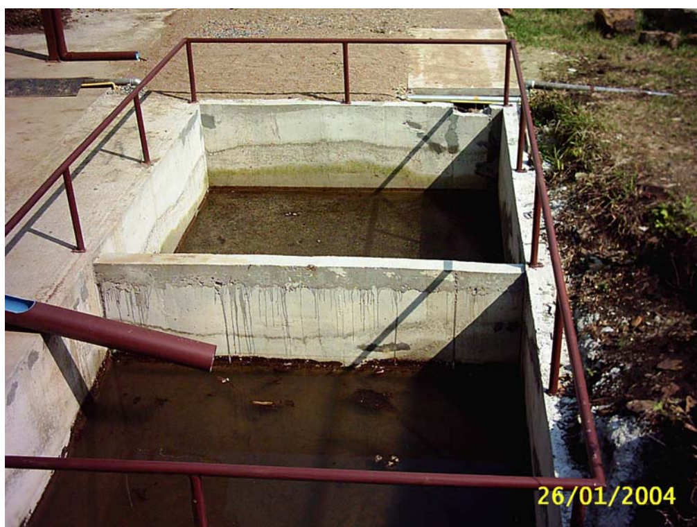
ภาพที่ 21 บ่อเก็บขังมูลคินทรายและน้ำขุ่นขึ้น
