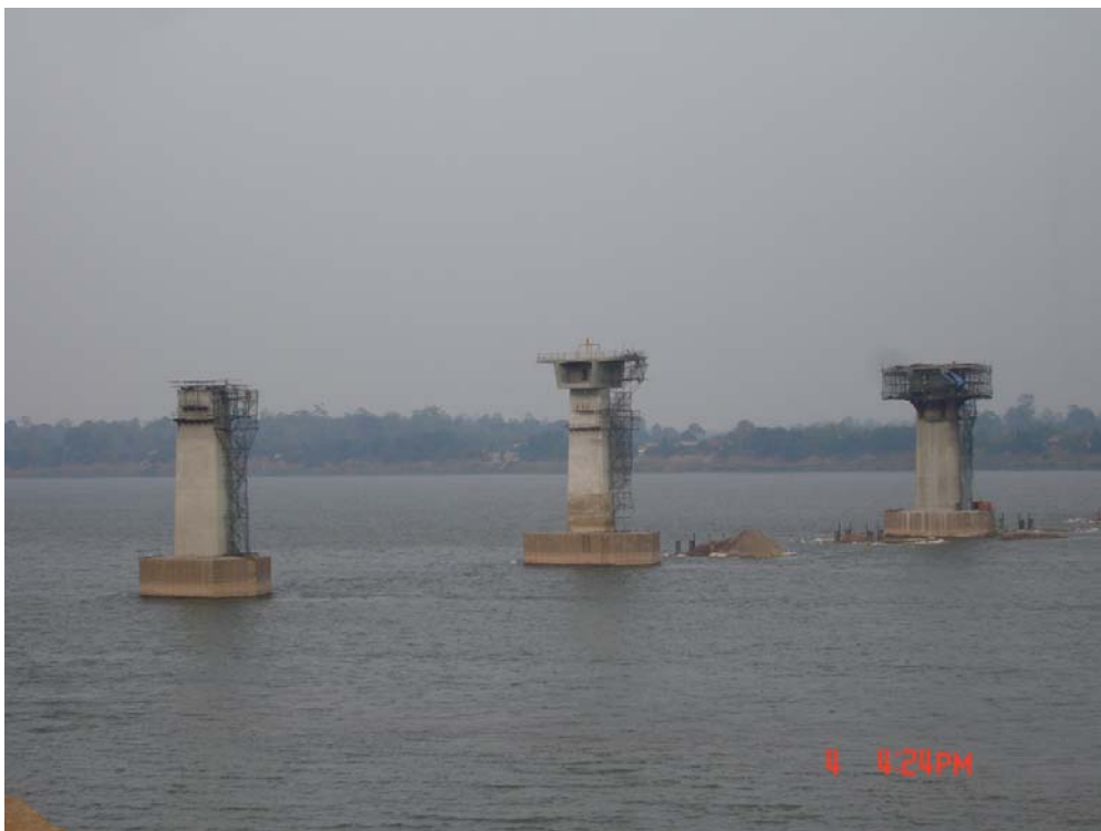
ภาพที่ 1 การก่อสร้างสะพานมิตรภาพแห่งที่ 2 จังหวัดมุกดาหาร ที่มา: ภาพถ่ายบริเวณก่อสร้างสะพานมิตรภาพแห่งที่ 2 จังหวัดมุกดาหาร
