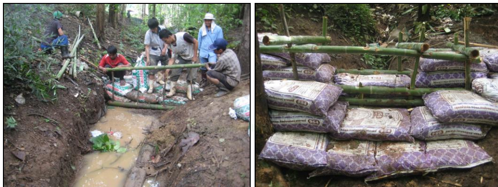
ภาพที่ 40 การซ่อมแซมฝายชะลอน้ำของชุมชน
