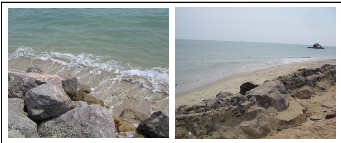
ภาพที่ 13 แนวหินทิ้งชายฝั่งหาดปึกเตียนเพื่อลดปัญหาการกัดเซาะชายฝั่ง
