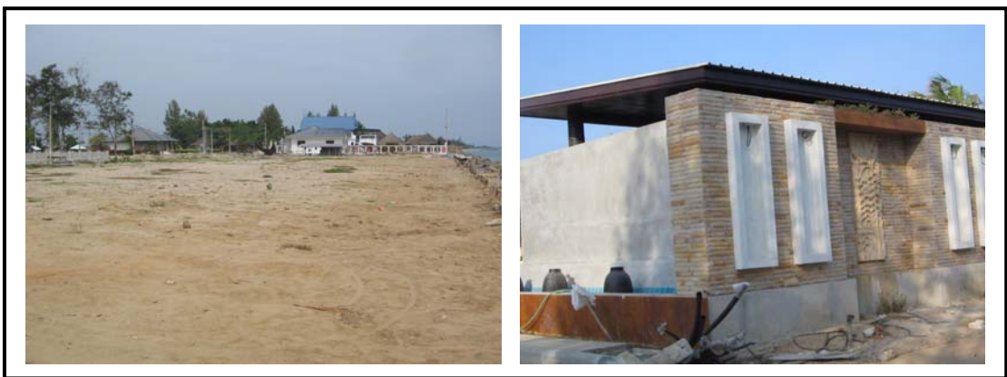
ภาพที่ 15 การปรับสภาพพื้นที่เพื่อก่อสร้างอาคารบริเวณชายหาดปึกเตียน
