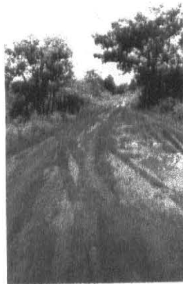
ภาพที่ 8 แสดงสภาพเส้นทางเดิม เป็นถนนเลียบเขตพื้นที่ทางด้านทิศใต้
