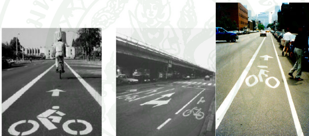
ภาพที่ 2.29 สัญลักษณ์ช่องทางจักรยาน (Stencils)
