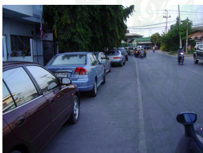
สภาพถนนกลาโหม
