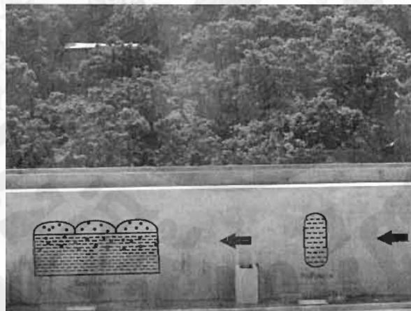
ภาพที่ 28 โรงไฟฟ้าพลังน้ำ
