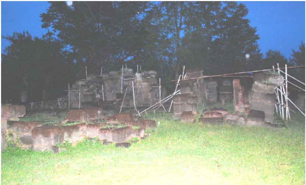
ภาพประกอบ 19 การบูรณะที่ยังไม่เสร็จสมบูรณ์หินที่เป็นสัต์ส่วนต่าง ๆ ของตัวอาคารกระจัดกระจายทั่วบริเวณของกุโพนระฆัง
