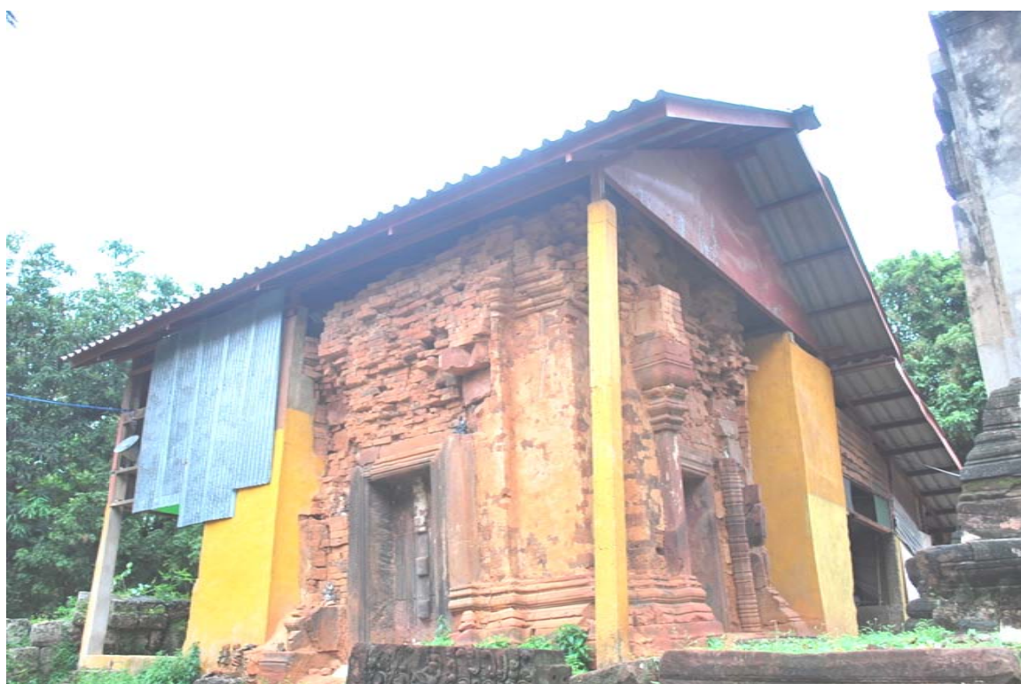
ภาพประกอบ 21 การต่อเติมซ่อมแซมตัวปราสาทของกุฏิพระโกนา
