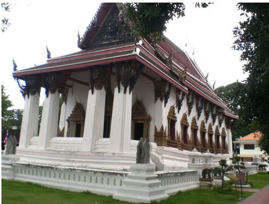
ภาพประกอบ 41 พระอุโบสถวัดสุวรรณคาราราม ฐานพระอุโบสถเป็นแบบตักท็องซ้างหรือท็องสำเกา
