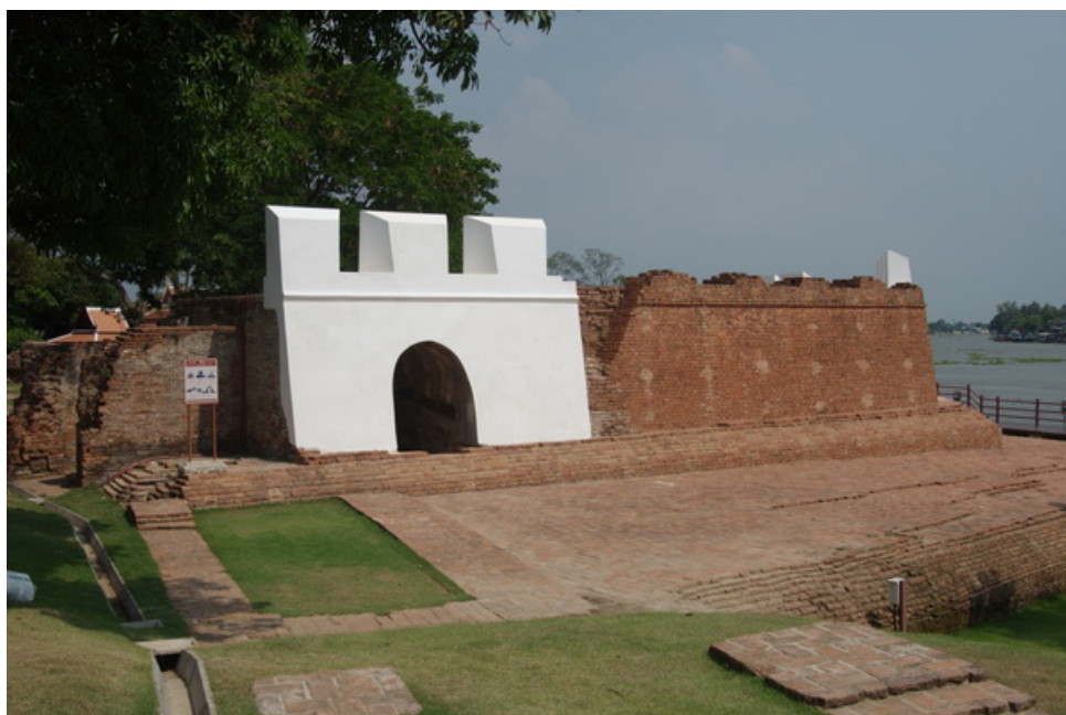
ภาพประกอบ 43 ป้อมเพชร ป้อมปราการขนาดใหญ่ที่สุดของกรุงศรีอยุธยา ก่อด้วยอิฐและศิลาแลง ซ้อนกัน 2 ชั้น
