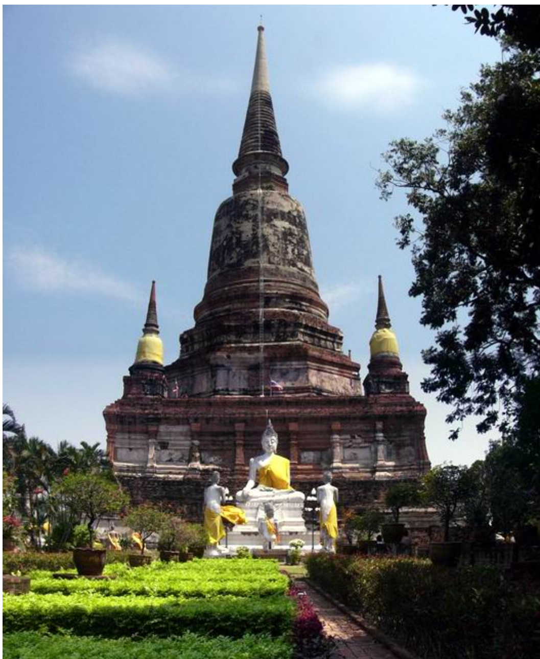
ภาพประกอบ 10 เจดีย์ชัยมงคล (ด้านหลัง) เป็นเจดีย์แปดเหลี่ยม มีเรือนธาตุ และมีฐานเป็นรูปแปดเหลี่ยมซ้อนกัน 3 ชั้น
