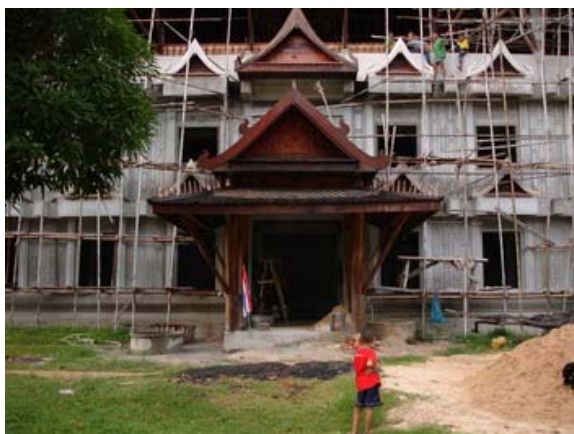
ภาพประกอบ 32 อาคารพิพิธภัณฑ์หลังใหม่ขณะก่อสร้าง
