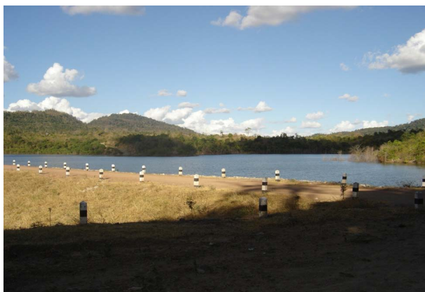
ภาพประกอบ 37 ทิวทัศน์บริเวณอ่างเก็บน้ำห้วยสมอทบ
