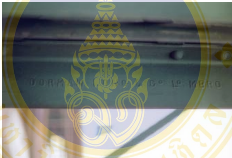
ภาพที่ 85 ชื่อบริษัทออร์แมน ลอง จำกัด ที่ประทับอยู่บนเหล็กโครงสร้างสะพานพุทธ
