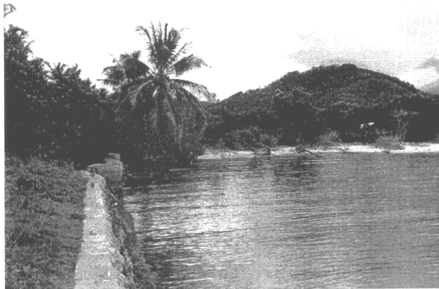
ภาพที่ 4.18 พื้นที่ที่ถูกกัดเซาะบริเวณปากคลองลิปะใหญ่ติดกับพื้นที่ตำรอน้ำ
