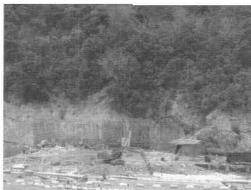
ภาพที่ 5.10 การก่อสร้างโรงพยาบาลน้ำเสีย ภัยพิบัติ
