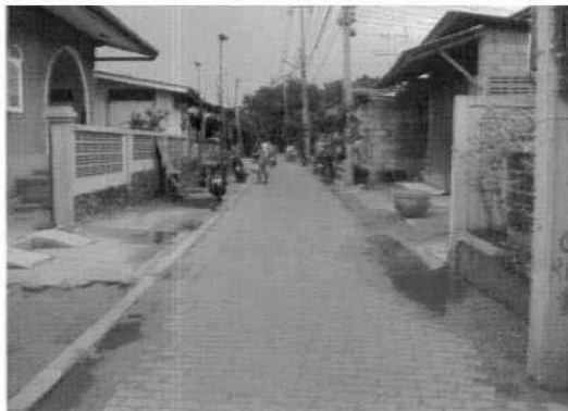
ภาพที่ 5.6 สภาพถนนบนเกาะล้าน
