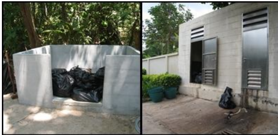
ภาพที่ 4.2 ที่พักขยะของโรงแรมในจังหวัดกระบี่แต่ไม่มีการปิดที่มิดชิด
