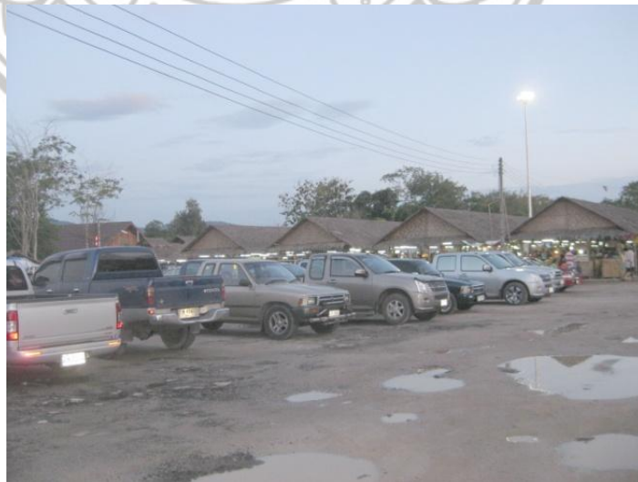
ภาพ 46 น้ำท่วมขังบริเวณลานจอดรถ
