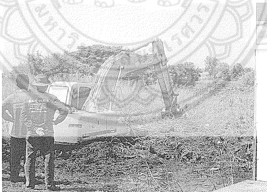
ภาพ 40 การใช้เครื่องจักรกลกำจัดวัชพืชน้ำ
