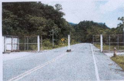
ถนนทางเข้าลาดยางตลอดสาย
