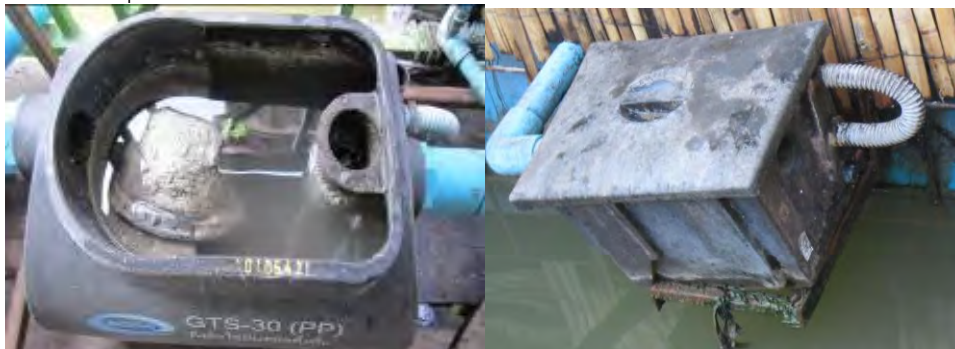
ภาพที่ ๔.๙ ลักษณะของการติดตั้งถังดักไขมันขนาด ๓๐ ลิตร
