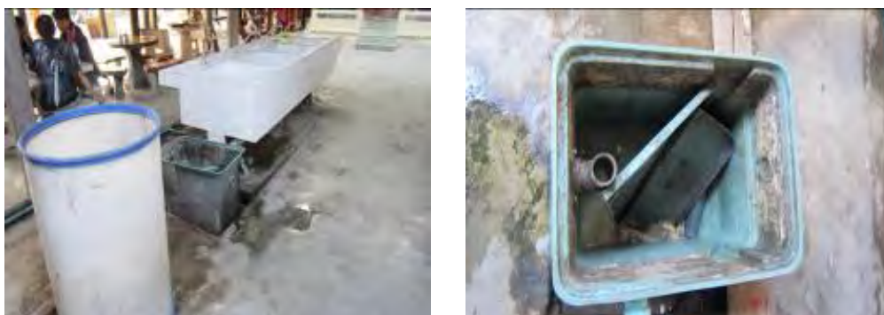
ภาพที่ ๔.๑๐ ลักษณะของการติดตั้งถังดักไขมันขนาด ๖๐ ลิตร
