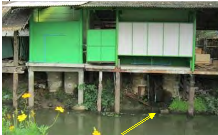
ภาพที่ ๔.๑๑ ลักษณะของการติดตั้งถังเกราะสำหรับห้องน้ำ
