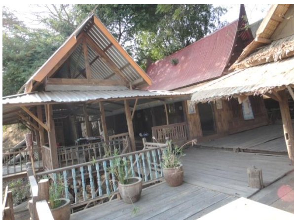
ภาพประกอบที่ 4.53 เรือนหลังที่ 5 เปลี่ยนรูปแบบและขนาดหลังคานอกชานด้านทิศใต้ พ.ศ.2553
