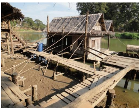
ภาพประกอบที่ 4.55 เรือนหลังที่ 7 เรือนแพฝาปะกน
