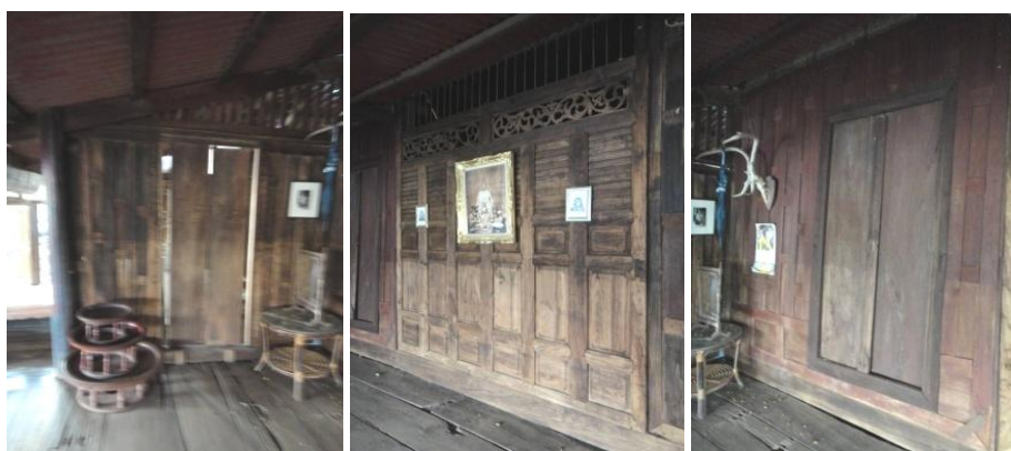
ภาพประกอบที่ 4.52 ฝาปะกน 3 แบบในเรือนหลังที่ 5
