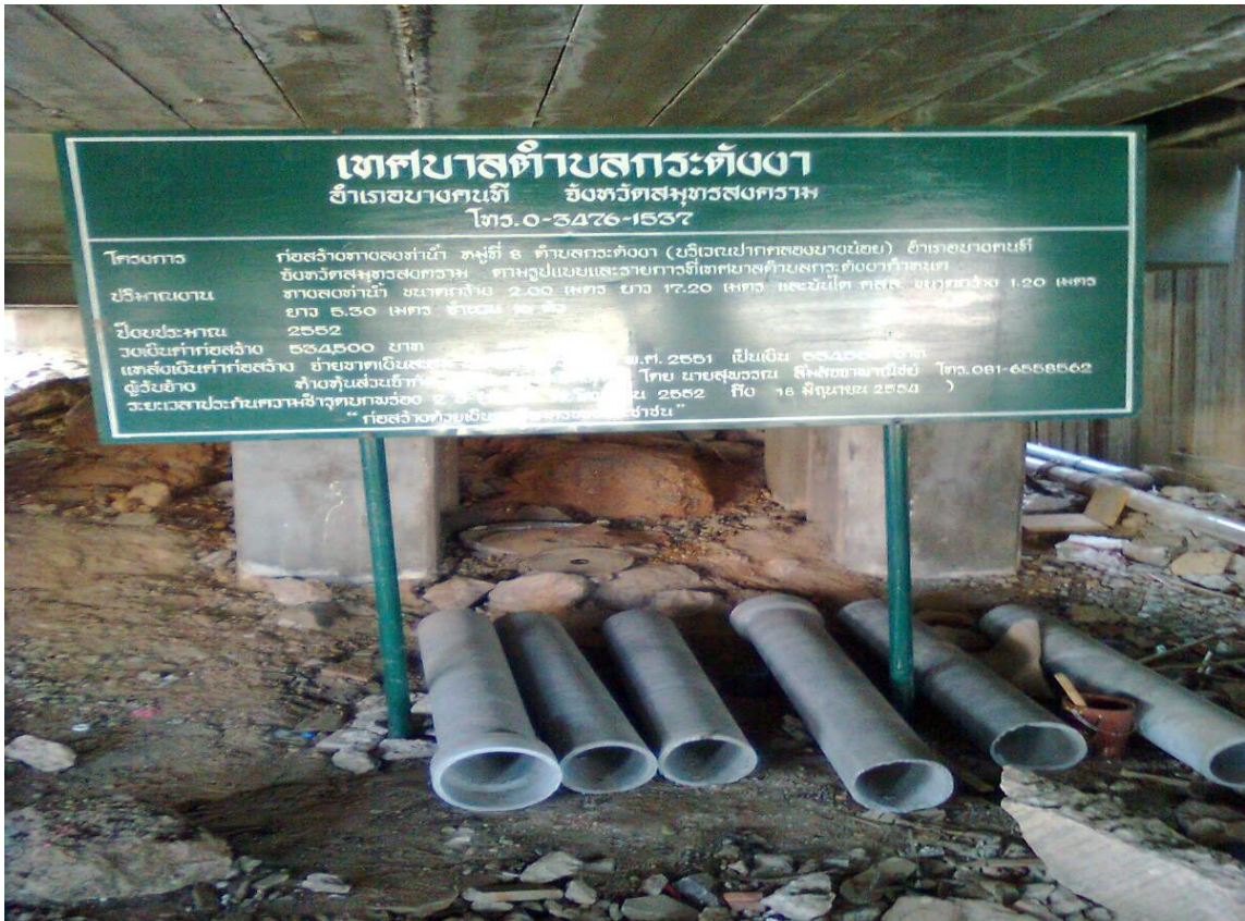
ภาพที่ 10 ปรับภูมิทัศน์ โครงการก่อสร้างทางเดินลงทำน้ำ บริเวณปากคลองบางน้อย
