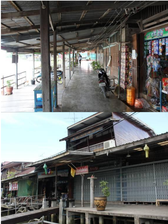
ภาพที่ 72-73 ลักษณะหลังคาคลุมทางเดินแบบเพิงสังกะสี (แบบที่ 1) แหล่งที่มา: นายวินัย หมั่นคดิธรรม ถ่ายภาพ
