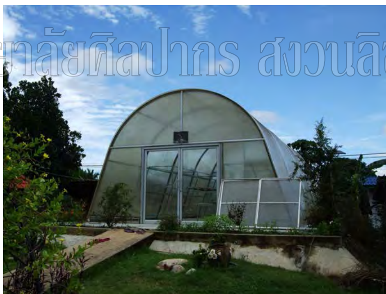
ภาพที่ 26 เตาอบพลังงานแสงอาทิตย์ใช้อบข้าวตังและผลไม้อบแห้ง
