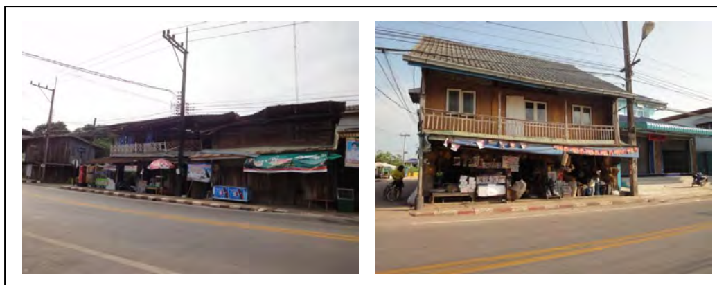
ภาพที่ 16 ภาพเรือนแถว ที่ทำการค้าขาย บริเวณริมถนนสาย ตราด – แหลมงอบ
