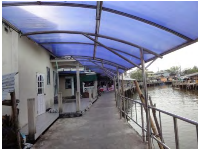
ภาพที่ 25 ภาพหลังคาคลุมทางเดินริมคลอง
