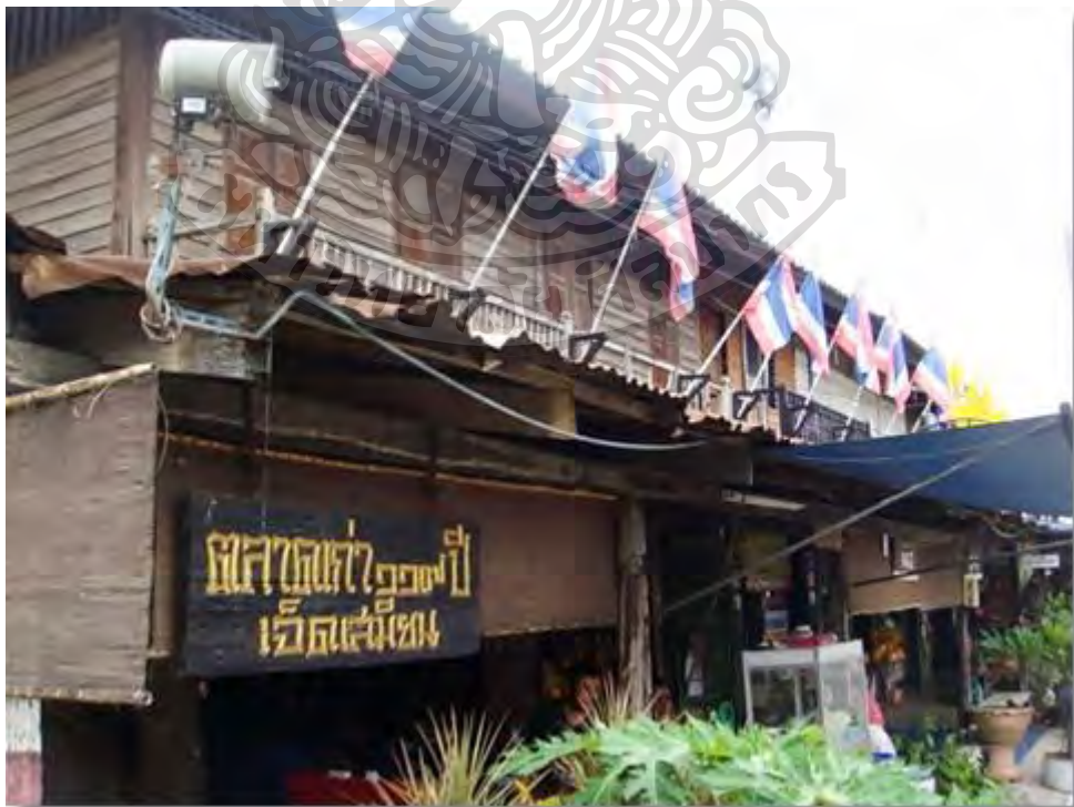
ภาพที่ 4 ห้องแถวไม้ 2 ชั้นบริเวณตลาดเก่า 119 ปีเจ็ดเสมียน
