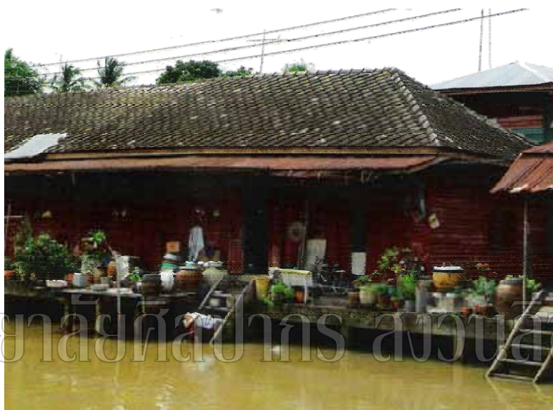
ภาพที่ 17 แสดงตัวอย่างเรือนแถวไม้ริมน้ำหลังคาปั้นหยาพบเห็นได้บริเวณริมสองฝั่งคลองอัมพวา
