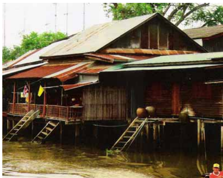
ภาพที่ 18 แสดงตัวอย่างเรือนแถวไม้ริมน้ำหลังคาจั่วเดี่ยวพบเห็นได้บริเวณริมสองฝั่งคลองอัมพวา
