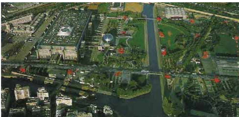
Figure 194 Lay-out of Cité des Sciences et de l'Industrie and Parc de la Villette
