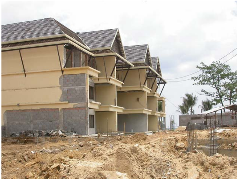
ภาพประกอบ 32 สถานที่พักบริเวณชายหาดนางทองที่อยู่ระหว่างการก่อสร้าง
