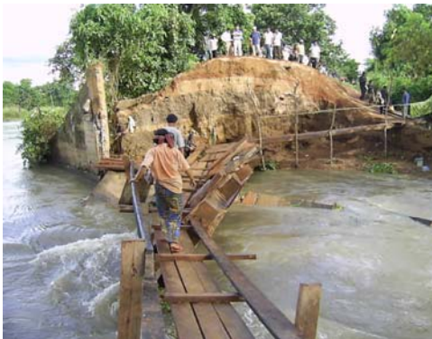
ภาพที่ 22 สภาพถนนบางช่วงถูกน้ำกัดเซาะเสียหายหนักในช่วงฤดูฝน
