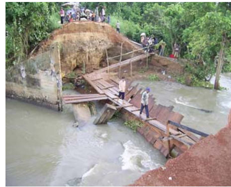
ภาพที่ 22 สภาพถนนบางช่วงถูกน้ำกัดเซาะเสียหายหนักในช่วงฤดูฝน
