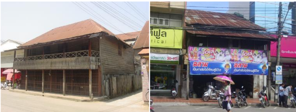
ภาพ 5-1 อาคารเรือนแถวพักอาศัยและค้าขายที่มีคุณค่าทางสถาปัตยกรรมริมถนนสุมนเทวราช
