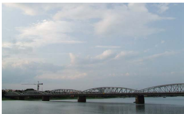
สะพานโค้งสร้างเตียน (Trang Tien)
