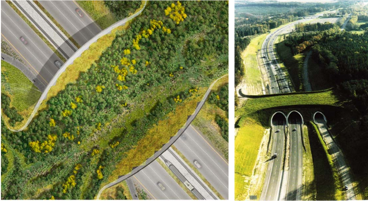
ภาพที่ 30 ภาพแสดงขนาดและการสร้างสภาพแวดล้อมเป็นธรรมชาติของแนวเชื่อมต่อสัตว์ป่าแบบทางข้าม (overpass corridor)
