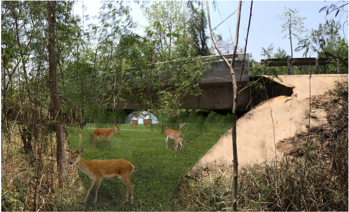
ภาพที่ 34 ทักษะภาพแสดงแนวเชื่อมต่อสัตว์ป่าแบบทางลอด (underpass) บริเวณคลองโคกเพ็ก
