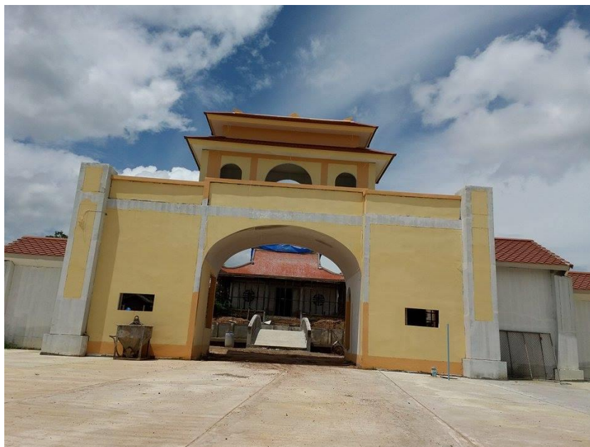
ภาพที่ 65 การก่อสร้างอนุสรณ์สถานท่านโฮจิมินห์ ที่มา : สุริยา คำหว่าน (2558)
