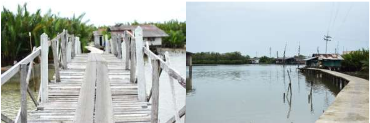
ภาพที่ 4.20-4.21 สะพานไม้และสะพานคอนกรีตในชุมชนประมงบ้านเกาะไชย
