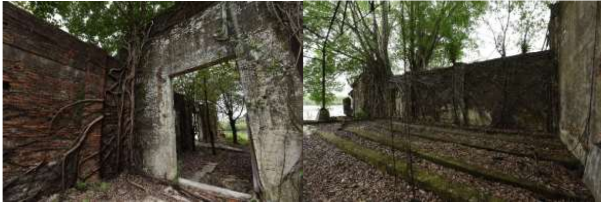
ภาพที่ 4.42 – 4.43 บรรยากาศภายในโรงสีไฟโบราณ
