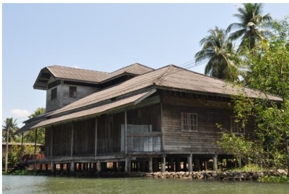
ภาพที่ 4.31 บ้านเรือนไทยหลังคาทรงมนิลา
