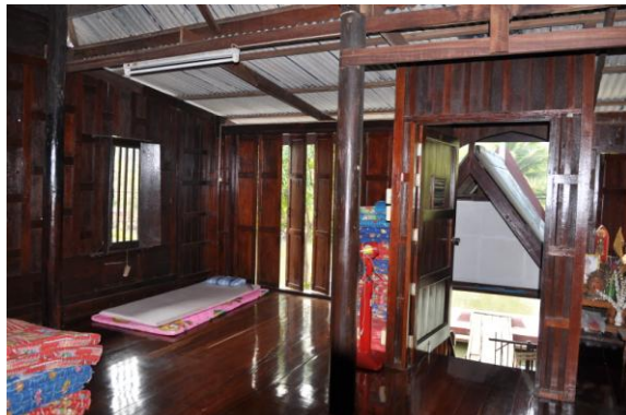
ภาพที่ 4.19 ฝาเรือนแบบฝาปะกนลูกฟัก
