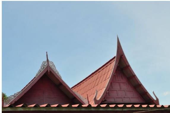
ภาพที่ 4.21 หลังคาจั่ว หน้าจั่วลูกฟัก มีหางปั้นลม
