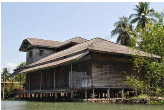
ภาพที่ 4.2 ลักษณะเรือนไทยหลังคามนิลาทรงเตี้ย
