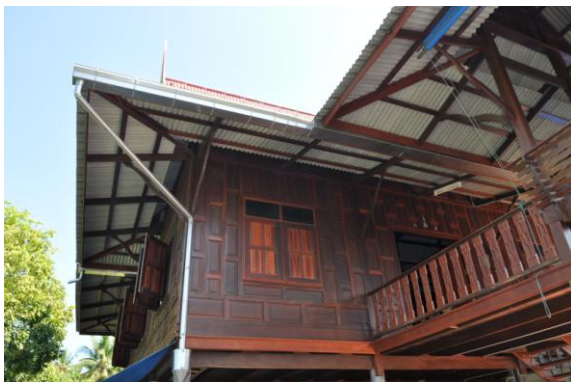
ภาพที่ 4.10 ฝาเรือนแบบฝาปะกนลูกฟัก
