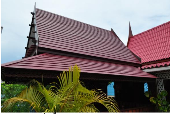
ภาพที่ 4.13 หลังคาจั่วปั้นลมรูปหางปลา ชายคาฉลุลายไม้สวยงาม
