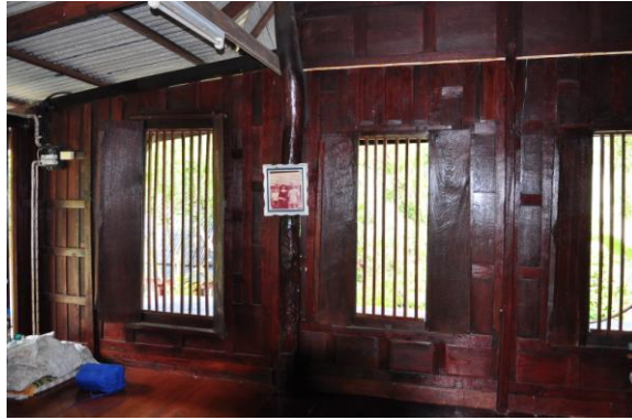
ภาพที่ 4.18 หน้าต่างติดระแนงไม้เพื่อกันขโมย
