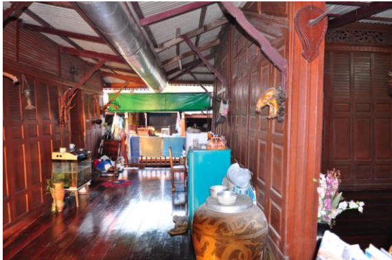
ภาพที่ 4.26 ฝาเรือนแบบฝาปะกนลูกฟัก
