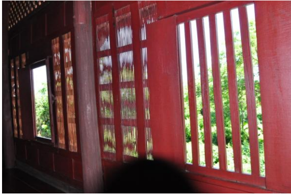
ภาพที่ 4.30 หน้าต่างติดระแนงไม้เพื่อกันขโมย
