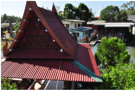
ภาพที่ 4.9 หลังคาทรงจั่ว หน้าจั่วลูกฟัก มีเพิงปั้นลม
