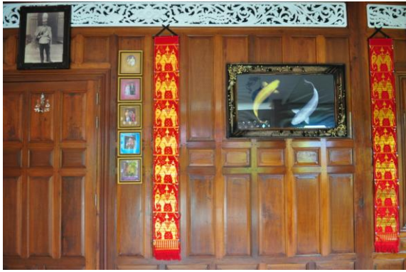
ภาพที่ 4.14 ฝาเรือนแบบฝาปะกนลูกฟัก
