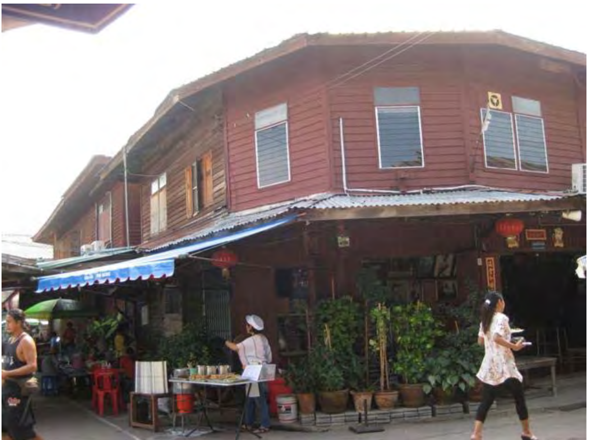
ภาพที่ 18 สภาพบ้านเรือนและร้านค้าในตลาดบางหลวง
