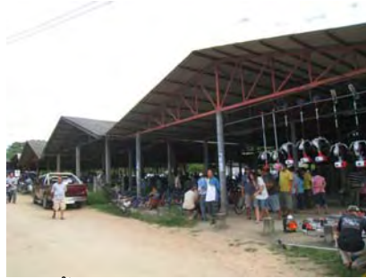
ภาพ 4-15 พื้นที่อาคารถาวร ภายในกาดทุ่งฟ้าบด
